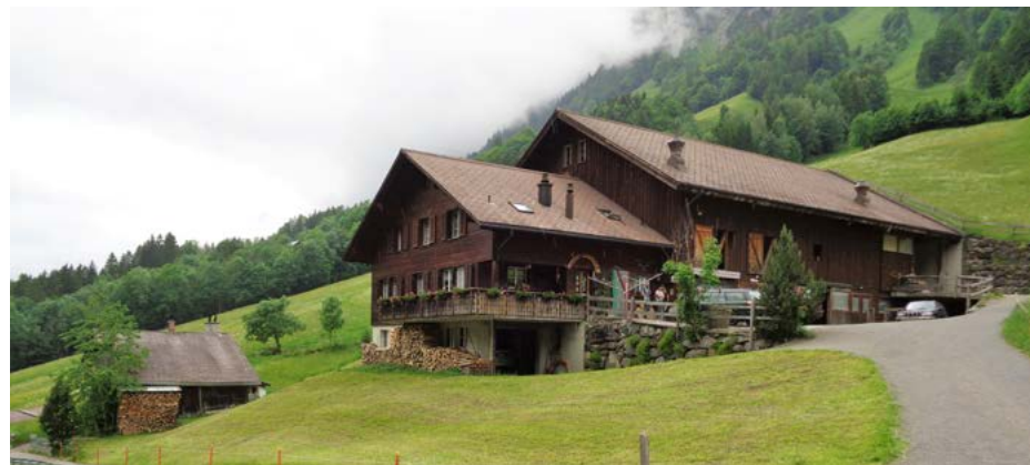
Der Heimbetrieb ist mit einem Schutzdamm (rechts) versehen, welcher bei einem allfälligen Lawinenabgang das Gebäude schützt.
