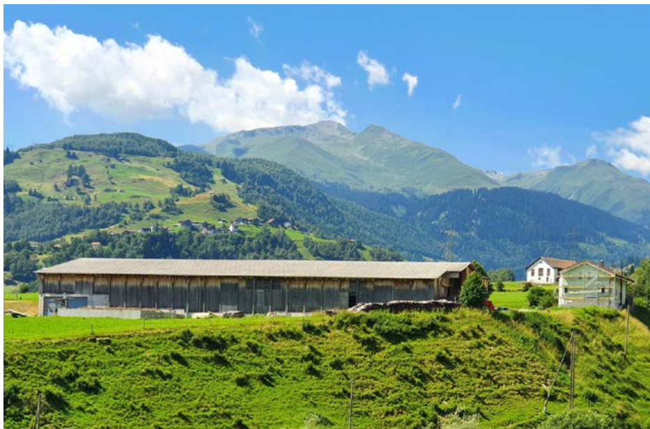
Der Laufstall des Klosterhofs Salaplauna wurde für Kühe mit Horn geplant und erbaut.
